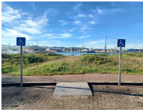
Plazas de aparcamiento para PMR y rampa accesible a la acera
