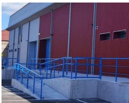
Rampa accesible desde el aparcamiento a los locales
