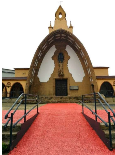
Rampas y barandillas accesibles a PMR en el acceso principal a la iglesia
