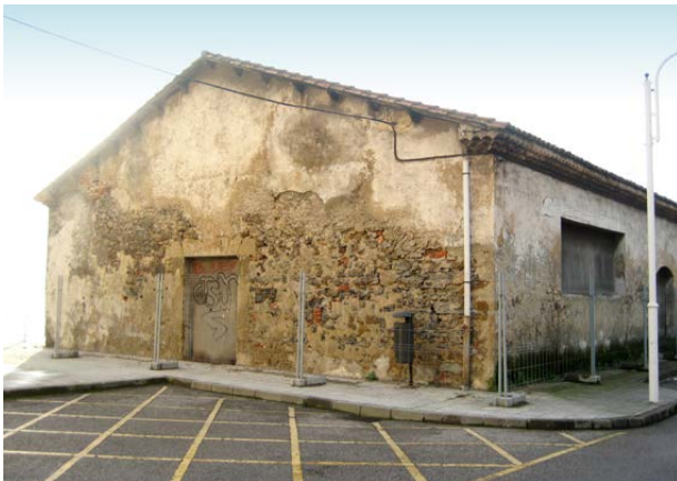
Estado inicial de la nave. Septiembre 2017 / Original condition of the unit. September 2017
