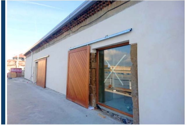
Estado de las obras. Mayo 2018 / Current state of construction work. May 2018
