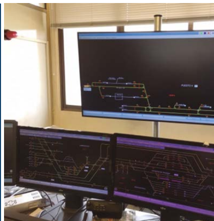
Ampliación del puesto del operador y del videowall en el Centro de Tráfico Centralizado de ArcelorMittal / Extension of operator job and video wall at the Centralised Traffic Centre of ArcelorMittal
