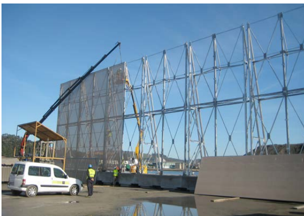
Pantalla modular porosa trasladable Fase I. Diciembre 2015 / Modular, movable porous shield Phase I, December 2015
