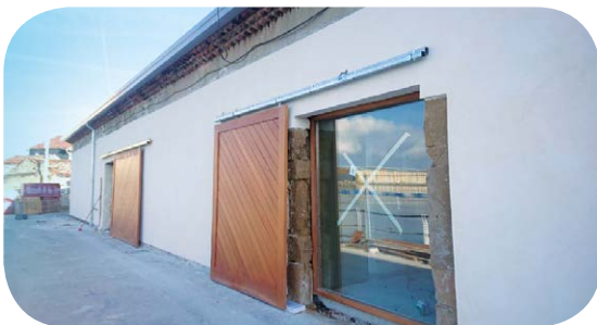
➤ Estado final de las obras. Diciembre 2018. / Final state of construction work. December 2018.
