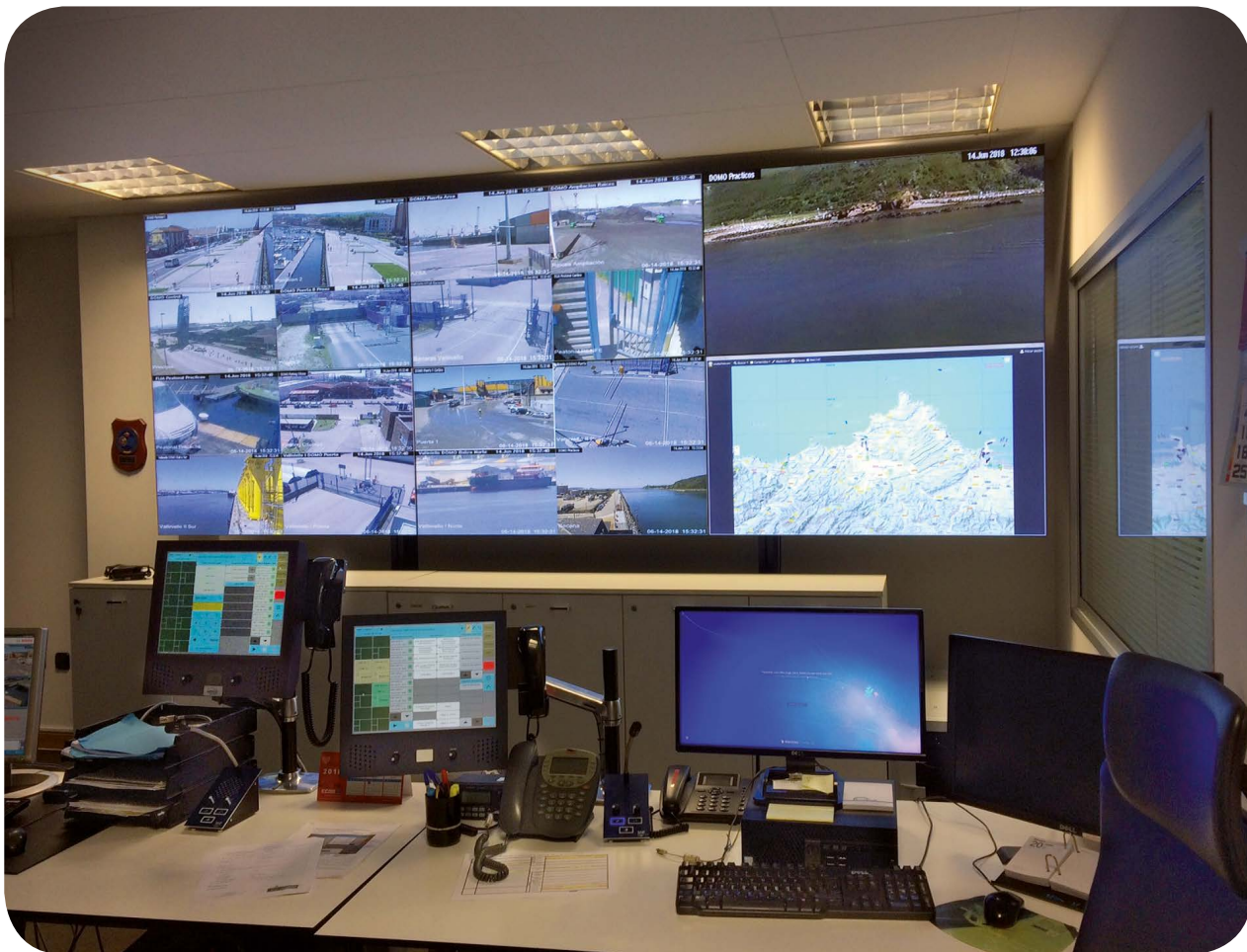
➤ Nuevo centro de Control del Puerto de Avilés con el SPA. Diciembre de 2019. / New control centre with SPA at the Port of Avilés. December 2019.
